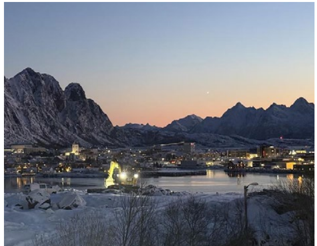
Utbygging av Svolvær Miljøstasjon pågår.
