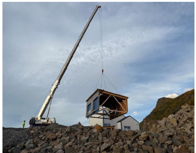
Bygg blir flyttet under utbygging av Svolvær Miljøstasjon.
